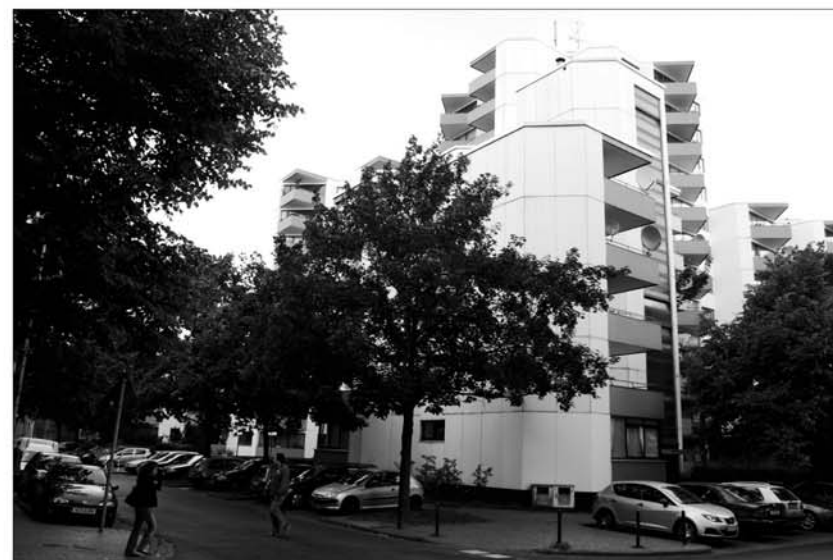
Wohnblock an der Mathildenstraße nach der Sanierung
