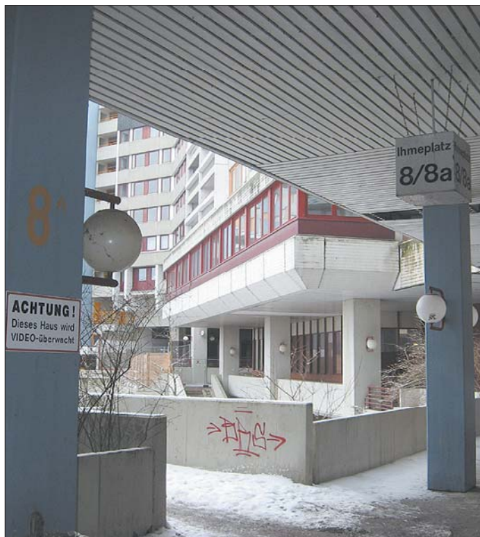
Das Ihmezentrum ist mit seinen vielen Verwinkelungen und dunklen Ecken nicht gerade ein Highlight an gelungener städtebaulich an Sicherheit orientierter Architektur. Foto: Wiesemann
