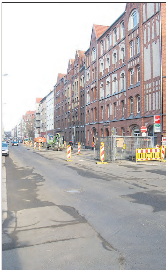
Soll nach Abschluss der Tiefbauarbeiten umgestaltet werden: der Kötnerholzweg. Foto: Wiesemann
