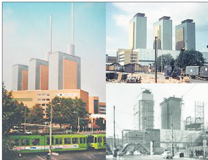
Werden und Wandel eines Heizkraftwerkes: das HKW Linden beim Bau in den 1960er Jahren und nach dem ersten Umbau (l.).
