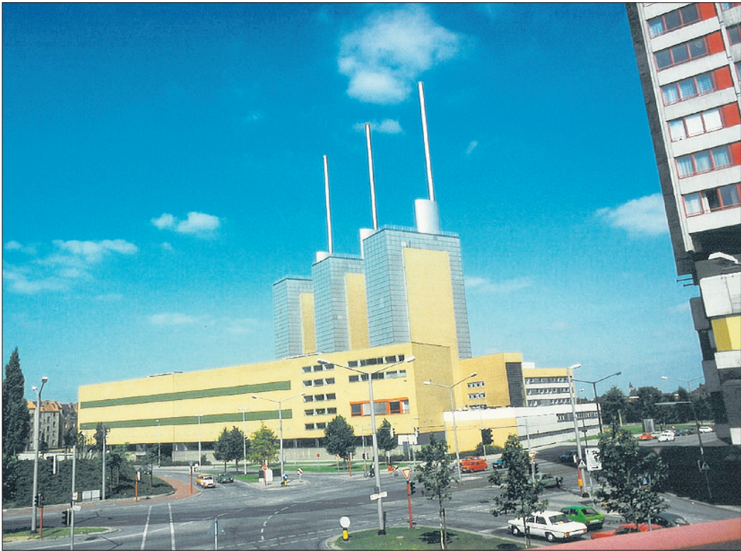
Damit die Bewohner der oberen Etagen des Ihmezentrums keine Abgase abbekommen, installierte man 1975 die 125 Meter hohen Schornsteine.
