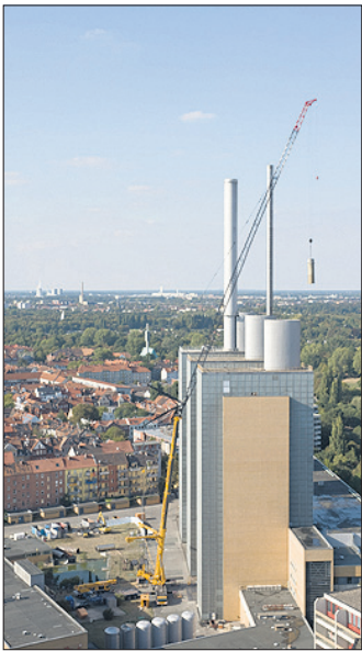
Damit die Bewohner der oberen Etagen des Ihmezentrums keine Abgase abbekommen, installierte man 1975 die 125 Meter hohen Schornsteine.
