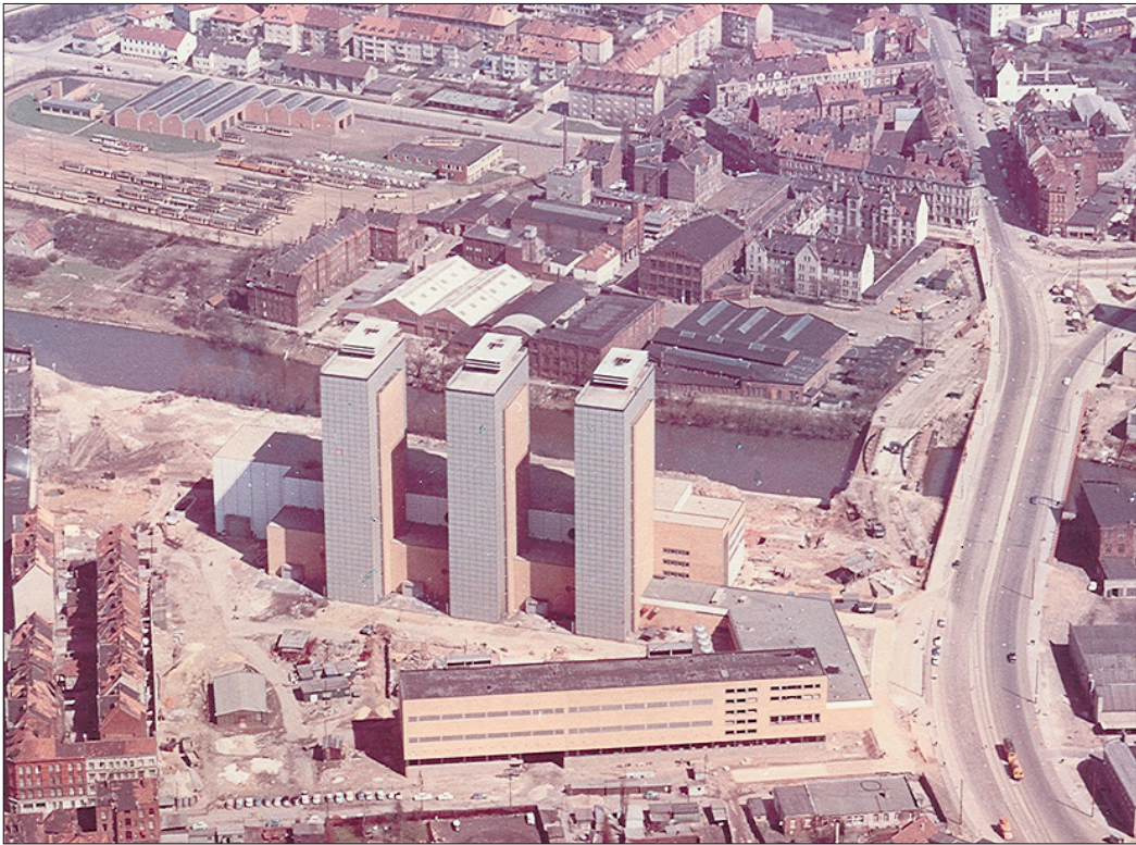
Das Heizkraftwerk Linden im Jahr 1964 aus der Vogelperspektive. Die damals noch kleinen Schornsteine waren nicht sichtbar in den Blöcken untergebracht.
